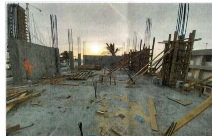
CIMBRADO DE COLUMNAS
