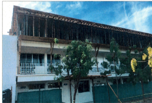
3.-COLADO DE LOSA
