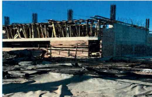
4.- ACOLADO DE MUROS LOSA
