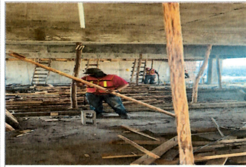
3.- DESIMBRADO DE LOSA
