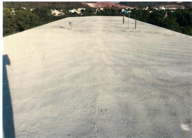
1.-IMPERMEABILIZACIÓN DE LOSA
