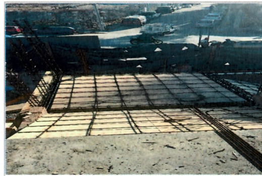
2.- ARMADO DE ESCALERA
