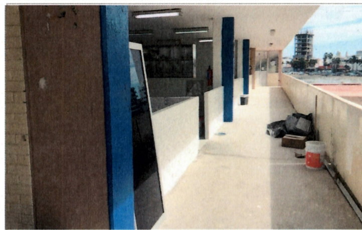
4.- INSTALACIÓN DE CANCELERÍA
